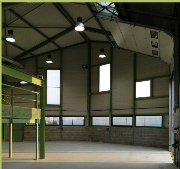
Intérieur du bâtiment industriel locatif
