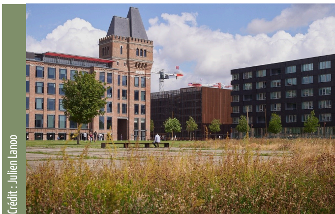
Le parking de 580 places Parking silo en acier Corten de l'îlot 23
