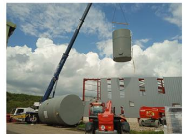
Mise en place des cuves d'hygiénisation dans le bâtiment en construction
